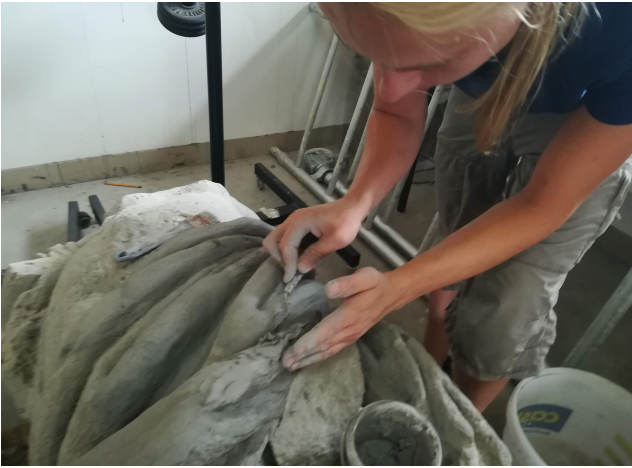
Proces uzupełniania ubytków
