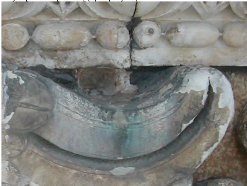
Rys. 5: zielone plamy oksydacji brązu (pocodzące z klamry) na mamurowym obiekcie dekoracyjnym.
