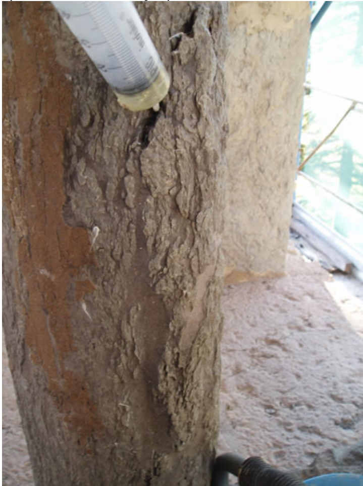
Rys. 11: wstrzykiwanie płynnej żywicy epoksydowej po uszczelnieniu szerszych pęknięć.
