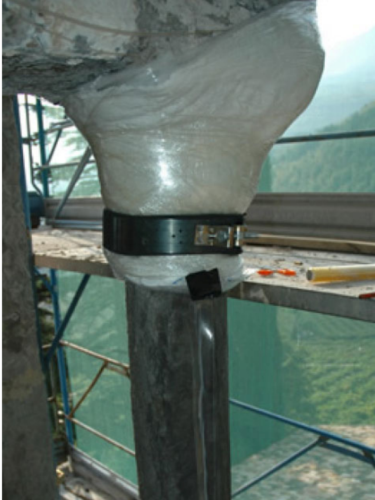
Rys. 12: impregnacja uszkodzonego piaskowca krzeminką etylową.
