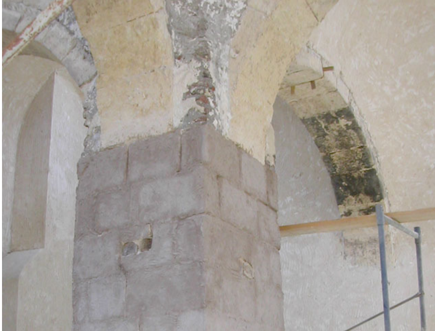
Rys. 8: szary, mokry seplilit położony na miękkim wapieniu do absorpcji soli z wewnątrz.
