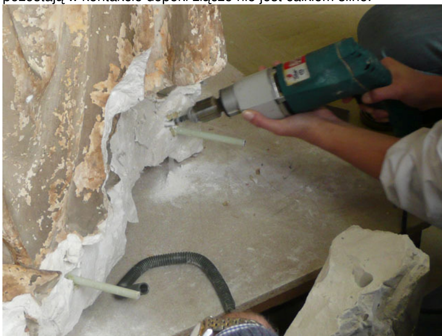
Rys. 13: usadowienie prętów z włókna szklanego na oderwanym rogu bloku marmurowego.
