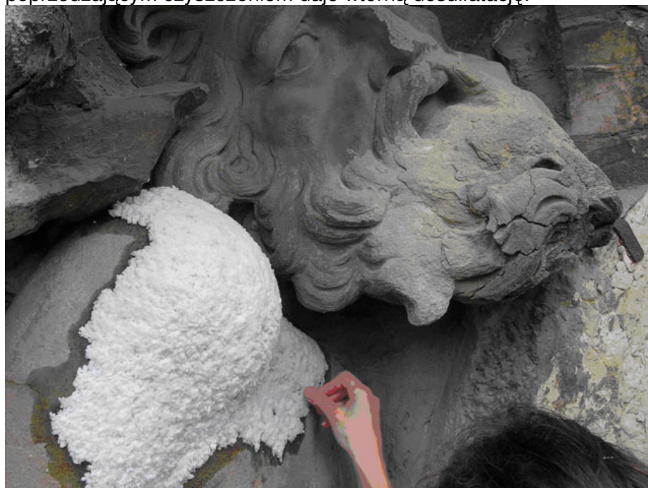
Rys. 7: papierowa papka przy operacji sulfatacji węglanem amoniaku na węglanowo zcementowanym piaskowcu.
