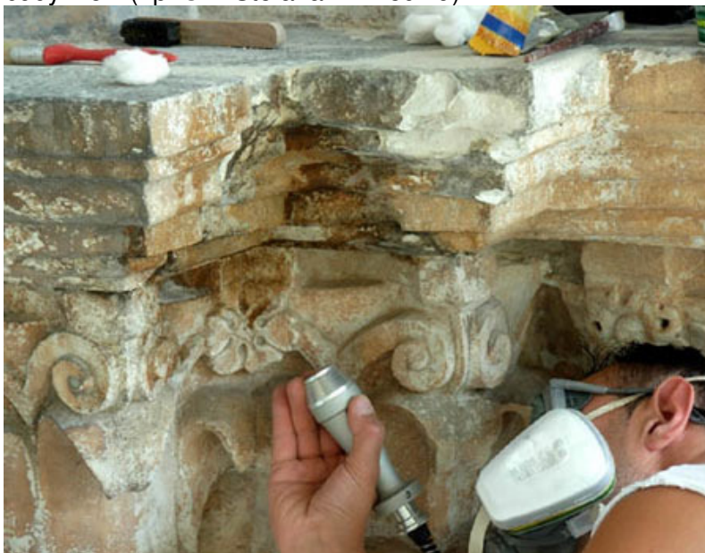
Rys. 9: usuwanie czarnych skorup na kamieniu wapiennym pistoletem laserowym.
