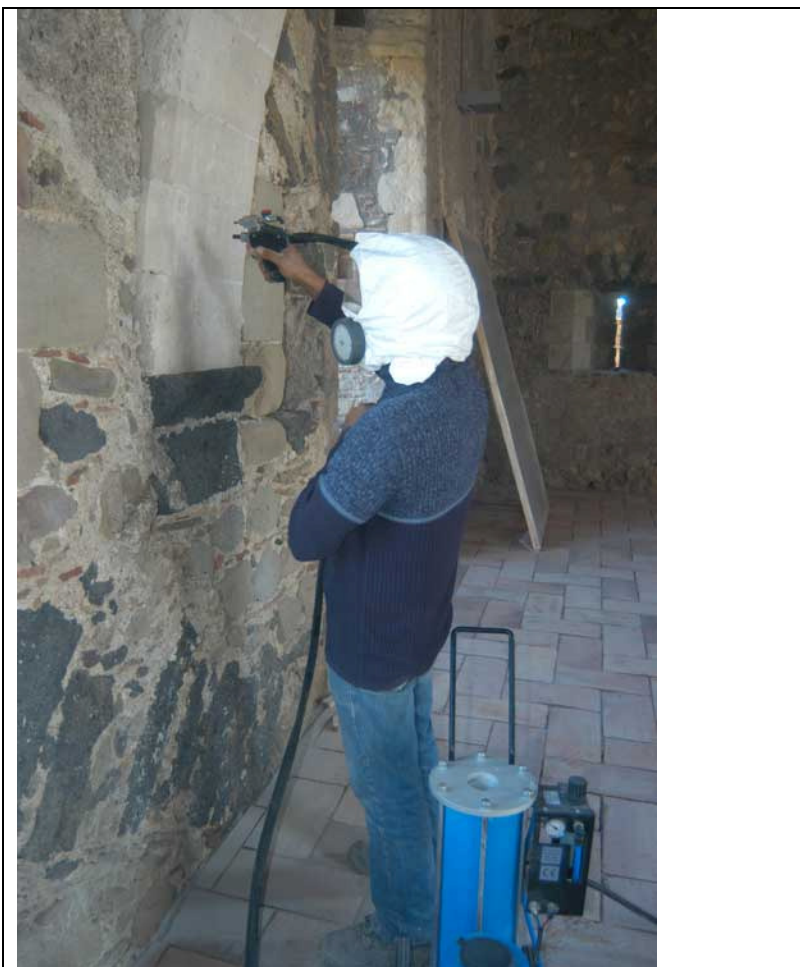
Rys. 6: mikropiaskowanie wewnętrznej arkady z wapienia.
