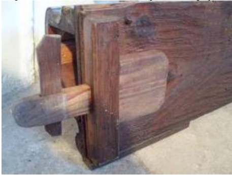
Fot.8. Drewniane łączenie pierwotnych
