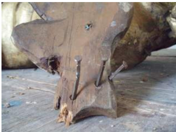
Fot 12. wtórne wzmocnienia -gwoździe
