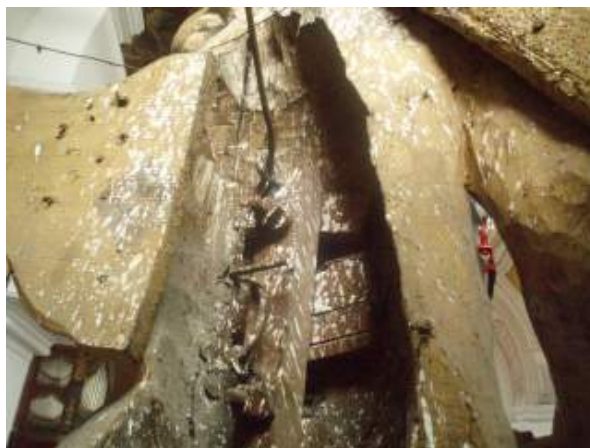
Fot 13 wtórne wzmocnienia- deski, śruby
